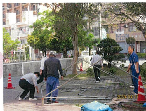
職員みんなで 仮設テント設置
